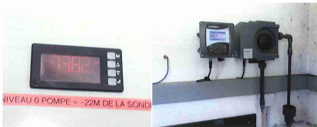
Photo de Gauche : lecture directe du piezometre sur l'armoire existante Photo de droite turbidimètre en fonctionnement
